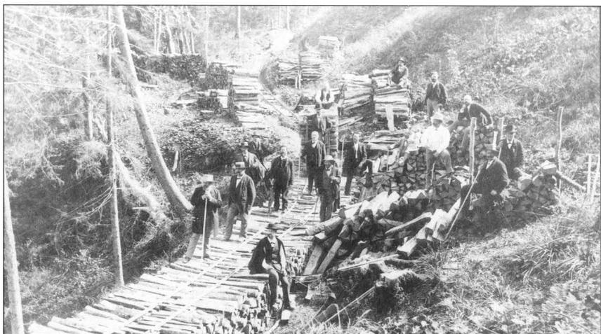
*Neben einer Permanentanlage gab es auch ein transportables Schiennetz, das demontiert und an einer andern Stelle des Sihlwalds wieder aufgebaut werden konnte wie hier auf einem Scheiterholzdamm auf rund 800 m ü. M.*
